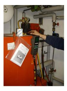
Dann wurde die Temperatur des Heizkessels als auch die Wassertemperatur durch Spülen der Leitungen auf minimum (HK - 28 °C) (WW – 14 °C) gebracht.
